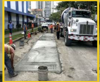
03- Obras y Adecuaciones
